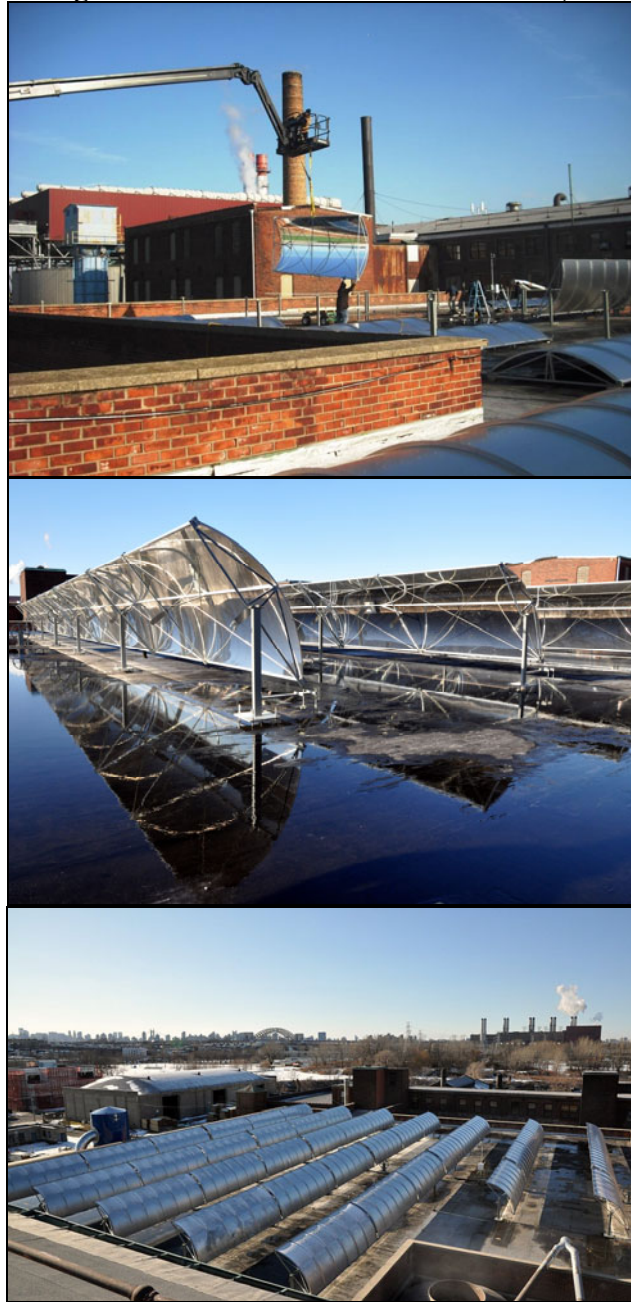
Figure 2: Abengoa IST Parabolic Solar Collectors (stowed position)
